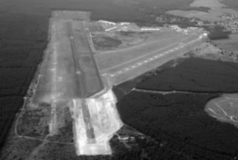
Auf dem Luftbild ist die Bahnverlängerung gut zu erkennen, die Asphaltierungsarbeiten haben planmäßig begonnen
