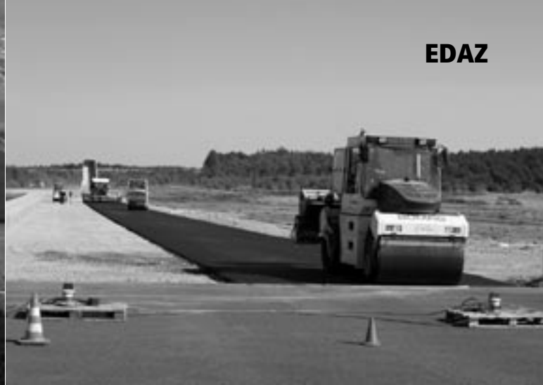
Auf dem Luftbild ist die Bahnverlängerung gut zu erkennen, die Asphaltierungsarbeiten haben planmäßig begonnen
